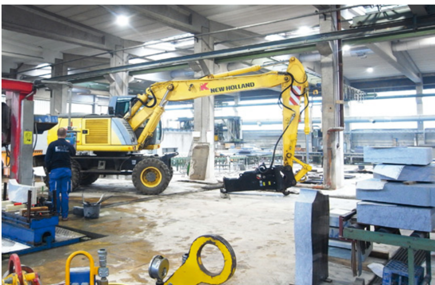
Mitten in der Betriebshalle wird ein neues Fundament geschaffen.
